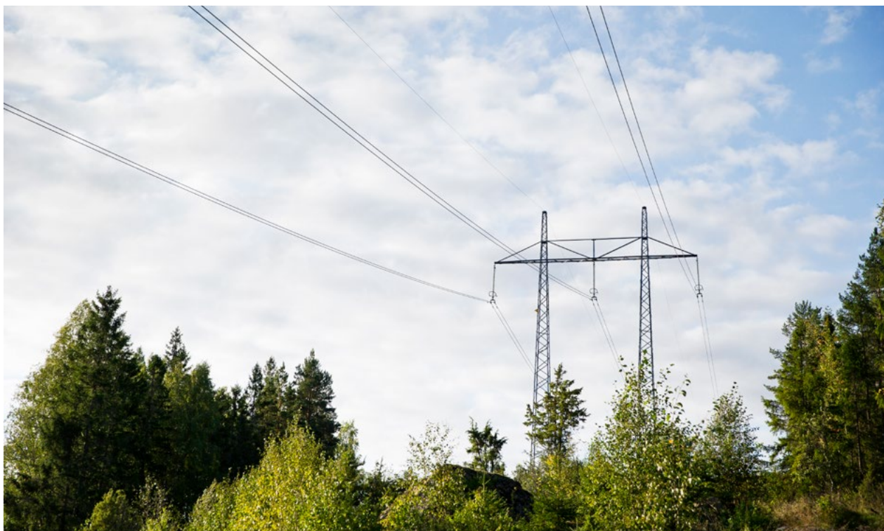
Foto: Øyvind Lund.
