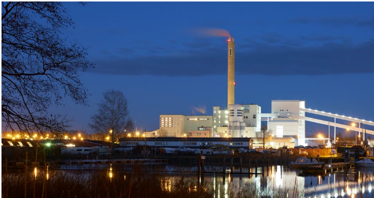
Kraftvärmeverket på Heden i Karlstad. Foto: Karlstads Energi.
